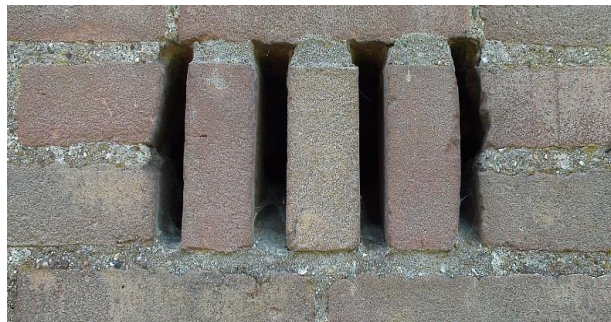
Figuur 11 Open stootvoegen die ook geschikt zijn voor
