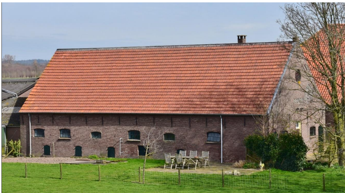
Stal bij boerderij Leuterveld (Rijndijk 6) met stalramen en mestluiken. De stal is in 1924 gebouwd en ontworpen door architect J. van Wamel.
