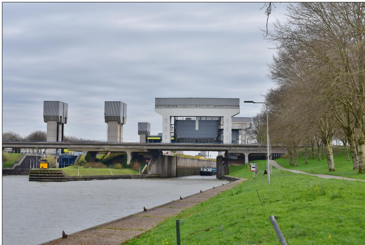
De Prinses Irenesluizen gezien vanaf het westen. Rechts zien we de oudste sluiskolk uit 1952, links de bredere sluiskolk die schepen met vier duwbakken door kan laten. Deze sluis is gebouwd in 1974.
