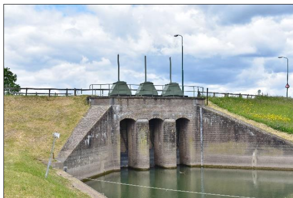
Links het Inundatiekanaal, rechts de inlaatsluis om water in de Kromme Rijn in te laten.
