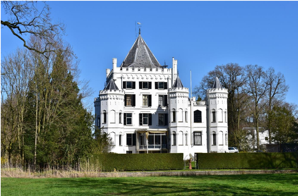
Buitenplaats Sandenburg aan de Langbroekerwetering is in het midden van de negentiende eeuw aangelegd door architect S.A. van Lunteren. In de toren is de onderbouw van de middeleeuwse woontoren opgenomen.
