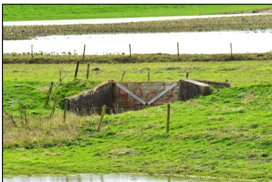
Sluisje in de zomerdijk van de Bosscherwaard.
