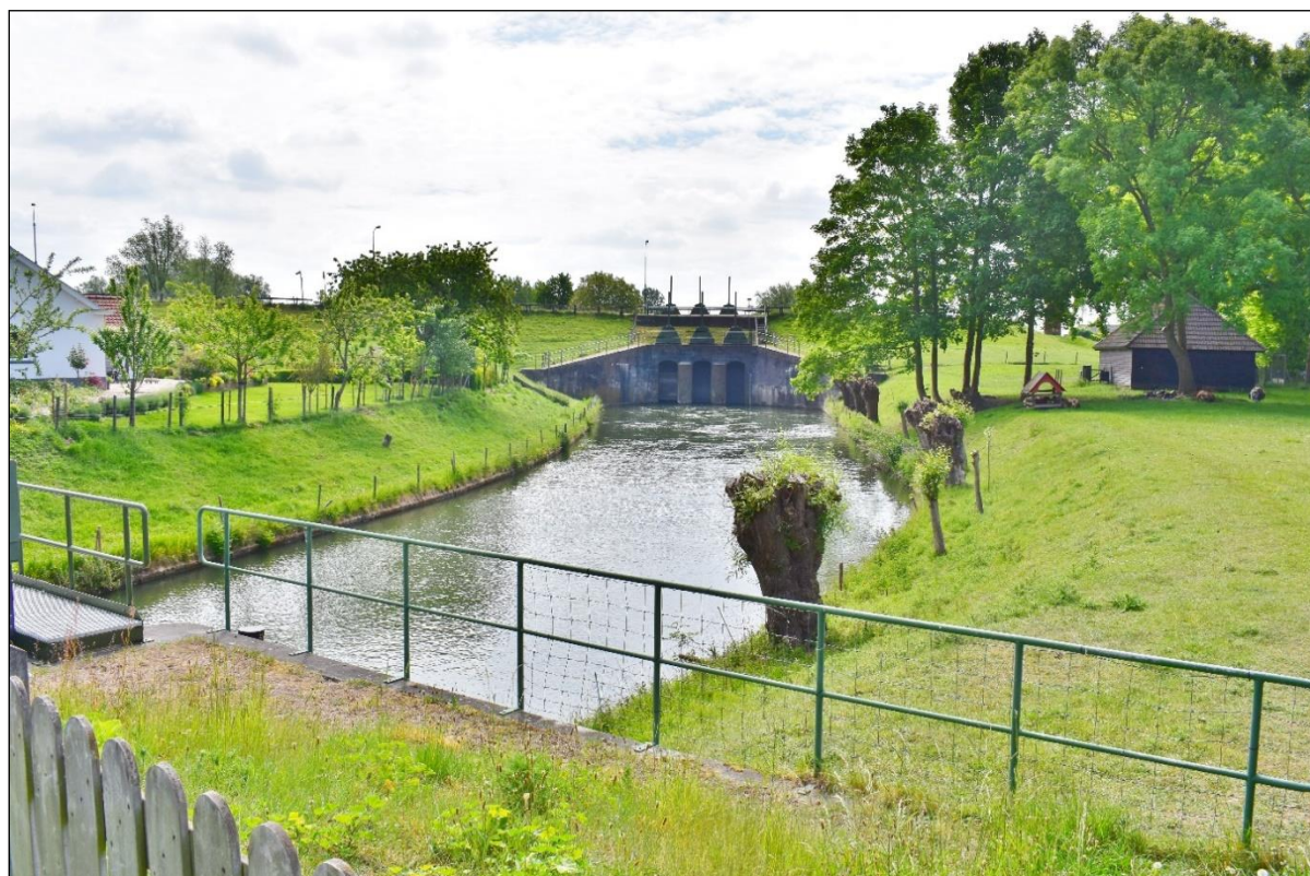
De kwelkom tussen de keersluis (op de voorgrond) en de inundatiesluis. Rechts staat de materiaalloods.
