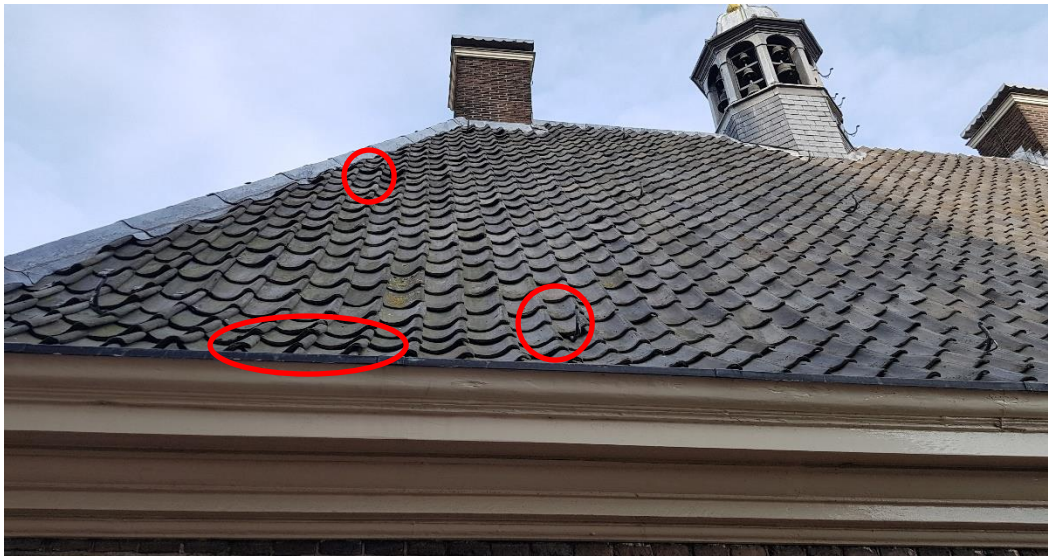
Enkele openingen onder de dakpannen die toegang tot ruimtes daaronder bieden voor vleermuizen, (Foto's Laneco).
