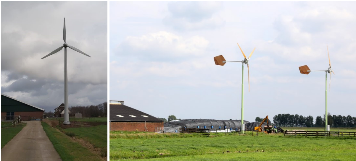
Afbeelding 2.2: voorbeelden windturbines van het type HAT, met rechts een E.A.Z.-Twaalf windturbine.
