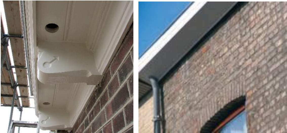
Figuur 8. Ruimte voor gierzwaluw in de gootbekisting of achter de dakgoot. Bron: gierzwaluwbescherming.nl en Kennisdocument Gierzwaluw BIJ 12).
