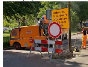
Foto: werkzaamheden Helmstok in Wijk bij Duurstede. 26-5-2020
